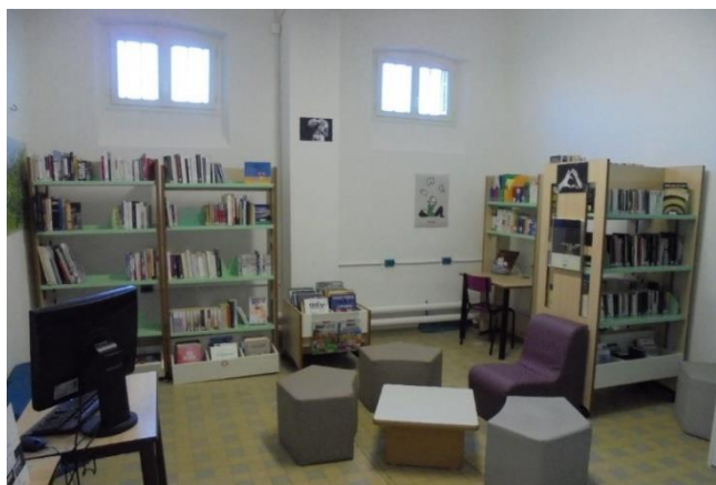
Bibliothèque du quartier femmes de Rouen en cours de rénovation
